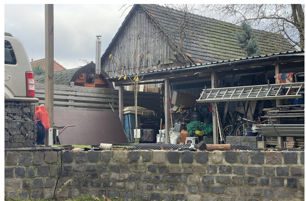
Bestand Lager und Nebengebäudebereich
